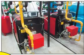
Газовая котельная на базе 2 котлов с двухступенчатыми горелками.
