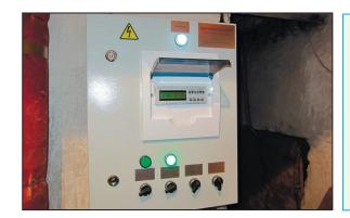
Шкаф управления и системы диспетчеризации ИТП, изготовлен на базе контроллера 1 поколения ИСУ-02.
