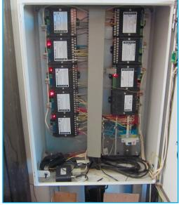
Газовая котельная ЮВЖД в г.Воронеже. Гигантский шкаф с применением большого количества отдельных блоков автоматики и программируемых контроллеров российского и импортного производства, соединенных в одну систему. Для обслуживания такой системы необходим штат высококвалифицированных и высокооплачиваемых специалистов.
