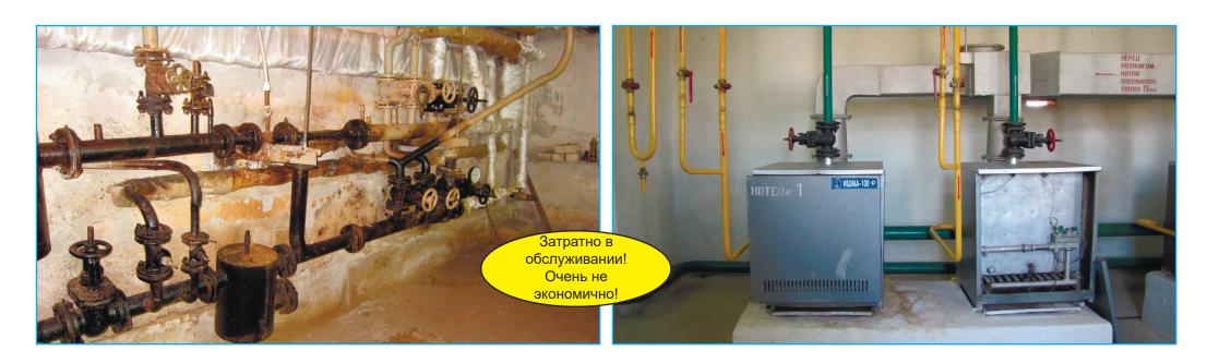
Состояние ИТП главного корпуса ВГУ (г.Воронеж). Из-за полного отсутствия автоматики переплата за отопление составляет до 30-50% в отопительный период.
