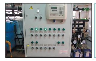
В процессе м о д е р н и з а ц и и установлен шкаф управления на базе контроллера 1 поколения ИСУ-08 и все необходимые датчики безопасности.
