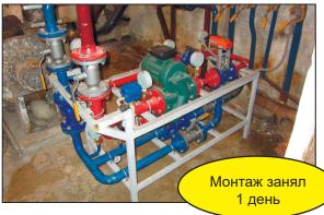
Тепловой пункт изготовлен на сборочной площадке ООО "УКонт", привезен в собранном виде и установлен в помещении Дома культуры вместе с щитом автоматики.
