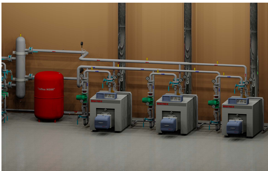
⊞ Рис. 1. Рассматриваемая котельная из трех котлов
