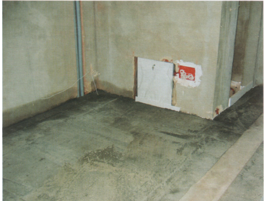
Рис. 1. Встроенный бокс для контроллера
